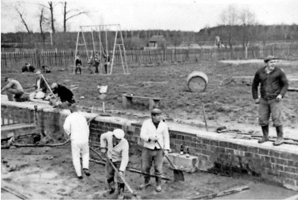
Bauarbeiten am Bad vor rund 40 Jahren.
